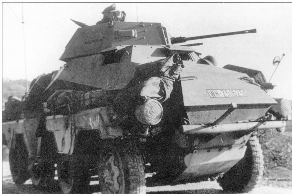
Бронеавтомобиль Sd.Kfz.232 (8-Rad) поздних выпусков. На корме машины установлена антенна с «метелкой»
