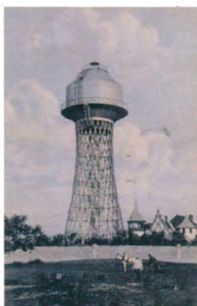
▲ Водонапорная башня в г. Николаеве, выполненная по проекту В. Г. Шухова и впервые в мире установленная и использованная в системе городского водоснабжения. Открытка начала XX века
