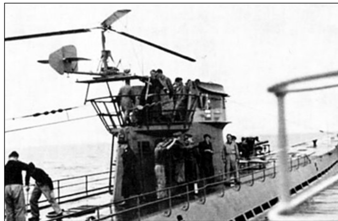
Змей-автожир Fa 330 на подводной лодке U-525 во время испытаний на Балтике, 1943 г.
