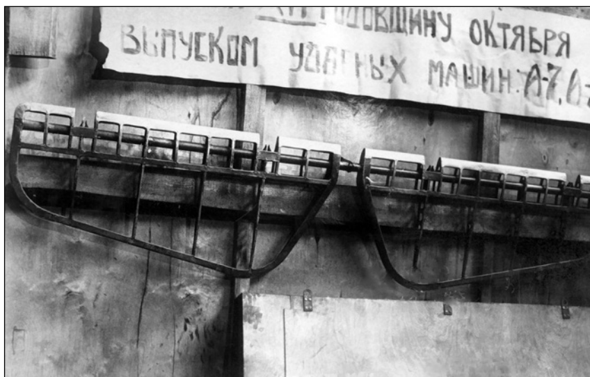
Слева: руль высоты автожира А-8 без полотняной обшивки на стене сборочного цеха ЗОК. На стене заметен фрагмент плаката: «Встретим XVI годовщину октября выпуском ударных машин А-7, А-8». Фото датировано 17 октября 1933 г.
