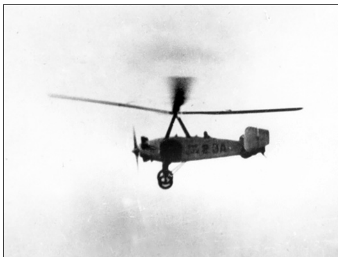
Автожир ЦАГИ 2-ЭА в полете над пригородами Москвы. Пилот управляет аппаратом из задней кабины. Фотоснимок выполнен в воздухе с летящего рядом самолета Р-5
