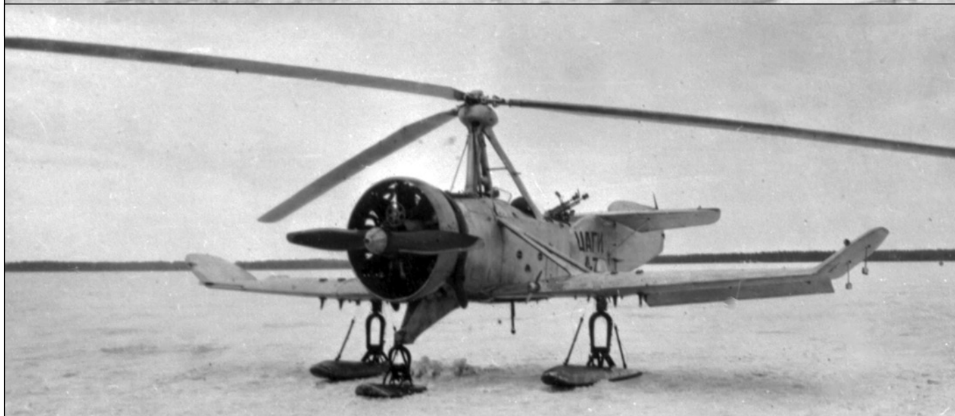
Первый экземпляр А-7 на испытаниях в НИИ ВВС. Зима 1935-36 гг.
