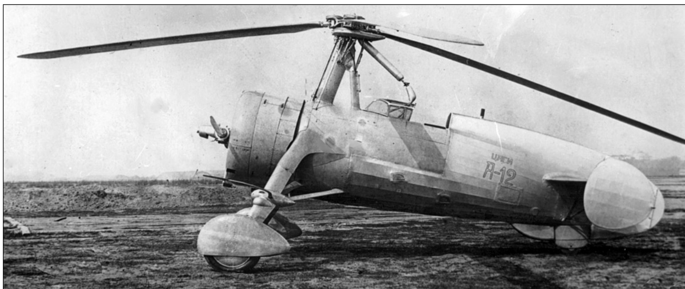
Автожир А-12 в процессе испытаний. Машина окрашена полностью в серебристый цвет. Можно разглядеть демпфирующие пружины, соединяющие головку ротора и стойку, термометр на заднем подкосе, маленькую стойку радиоантенны на обтекателе за головой пилота
