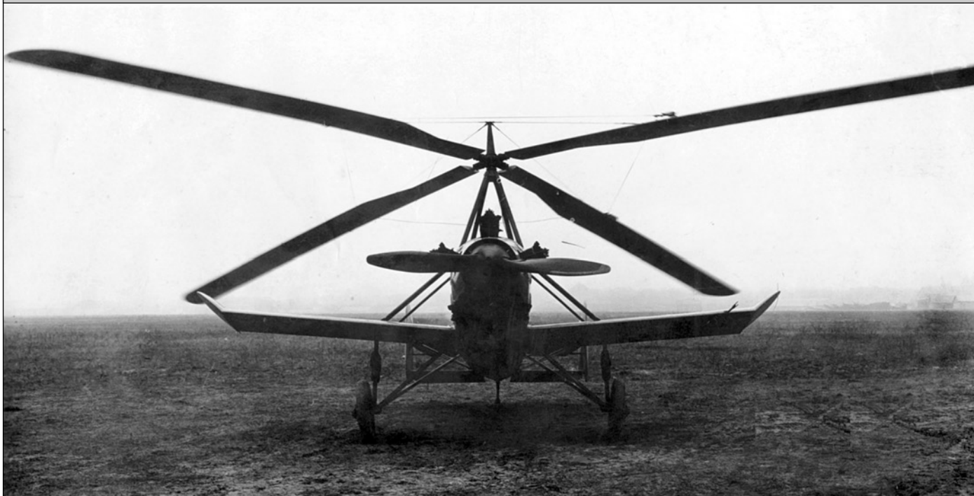
ЦАГИ 2-ЭА – первый экспериментальный автожир конструкции Центрального аэрогидродинамического института. Снимок сделан 21 ноября 1931 г. на Центральном аэродроме Москвы, через три дня после первого полета С.А. Корзинщикова
