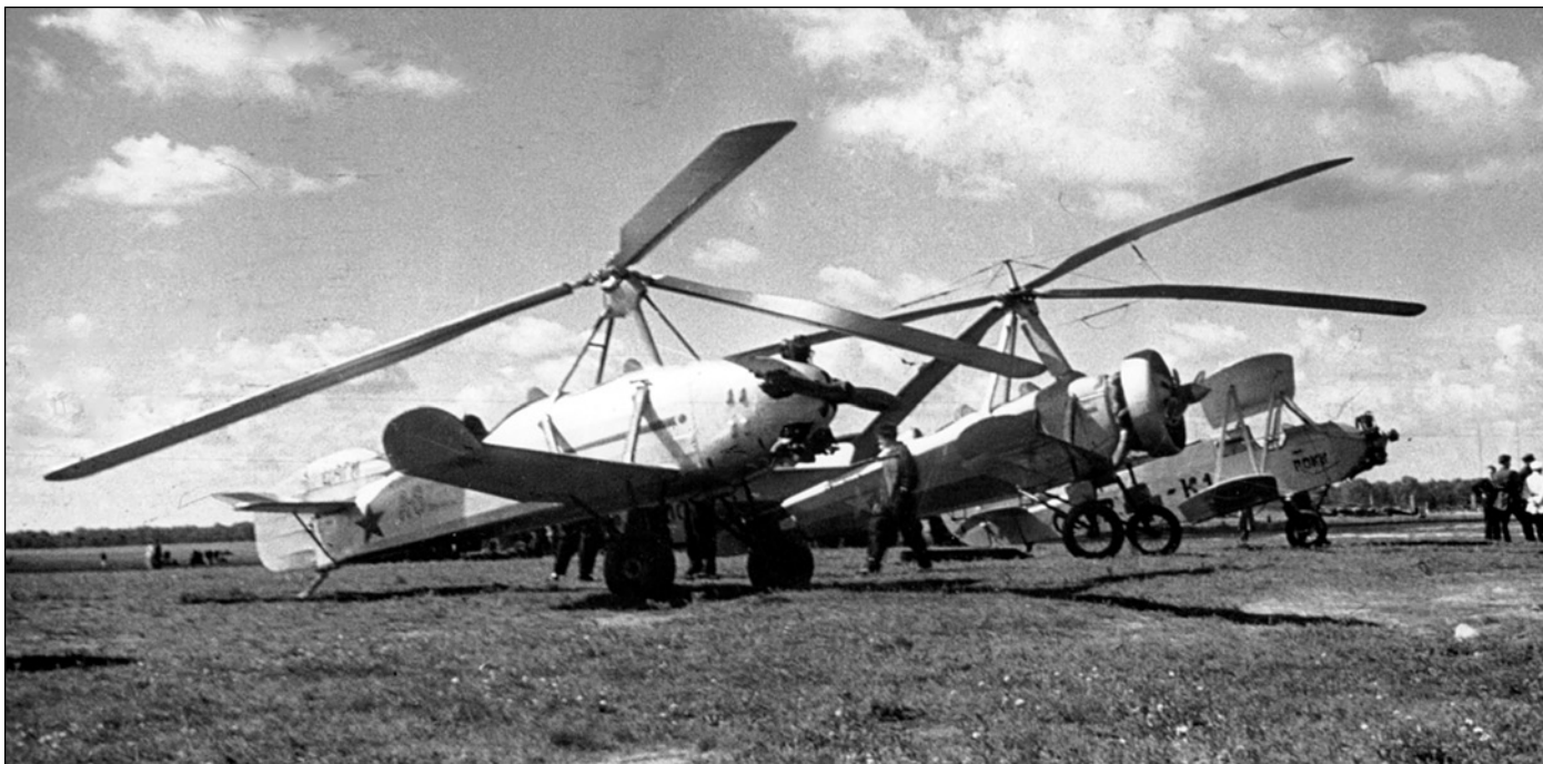
Автожиры А-6 и А-4 рядом с самолетом С-2 (санитарный вариант У-2 с опознавательным знаком СССР-К1) на Центральном аэродроме Москвы летом 1933 г. Дополнительные вертикальные кили на стабилизаторе еще не установлены, передняя стойка кабана ротора снабжена узким обтекателем
