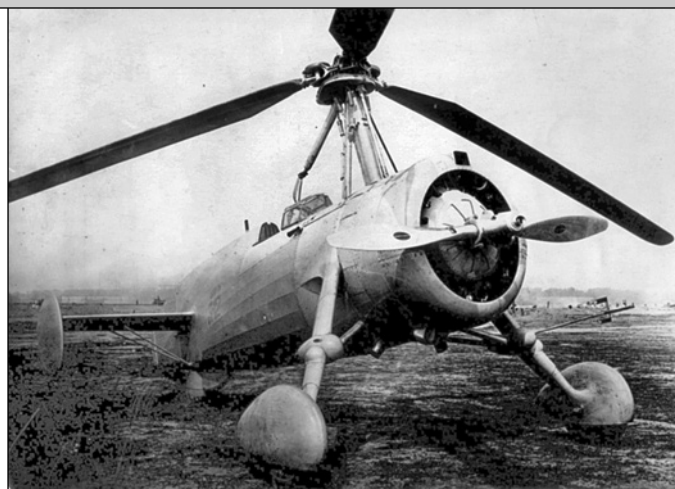
Автожир А-12 в процессе испытаний. Машина окрашена полностью в серебристый цвет. Можно разглядеть демпфирующие пружины, соединяющие головку ротора и стойку, термометр на заднем подкосе, маленькую стойку радиоантенны на обтекателе за головой пилота
