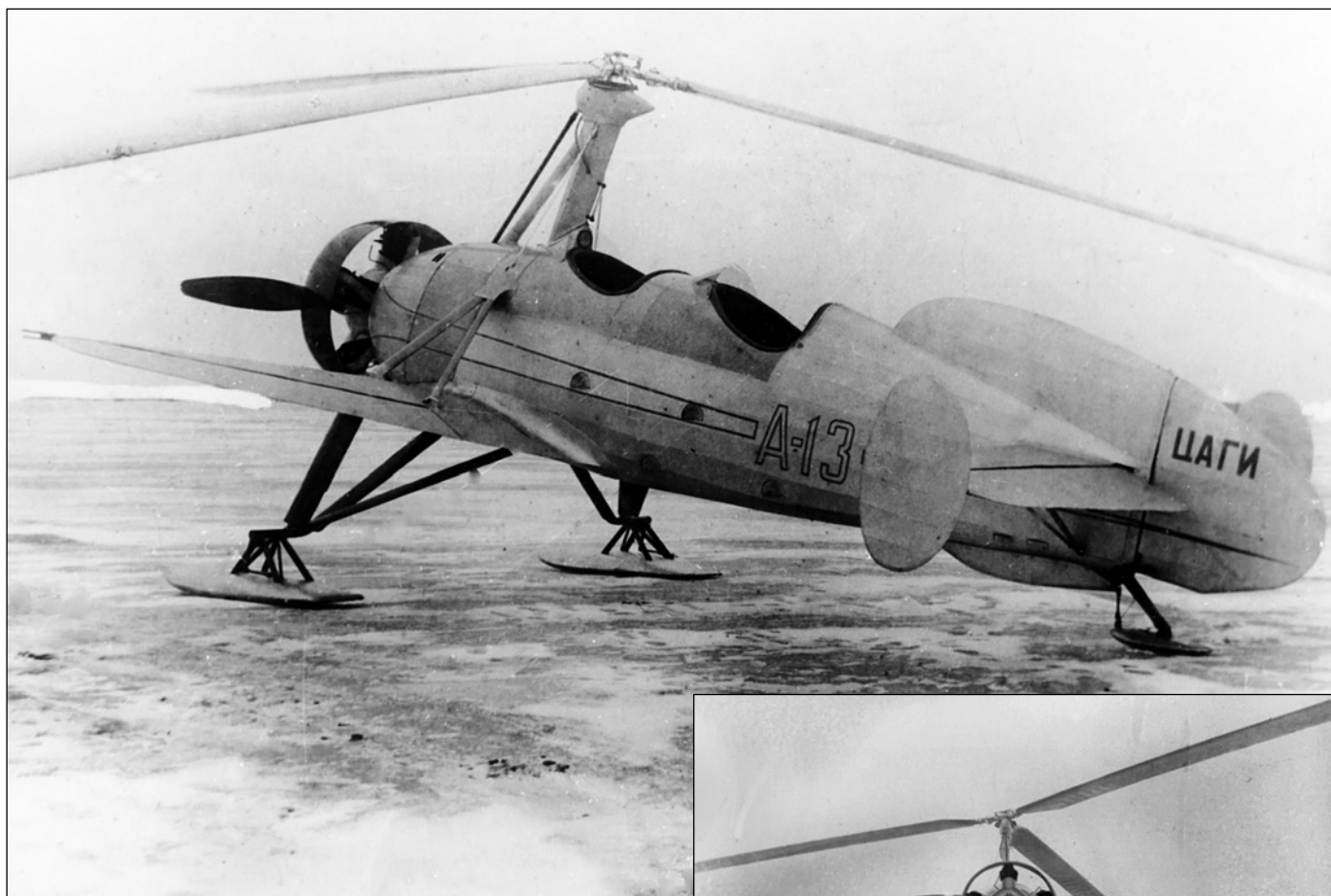
Виды автожира А-13 в процессе испытаний на лыжном шасси в марте 1936 г.
