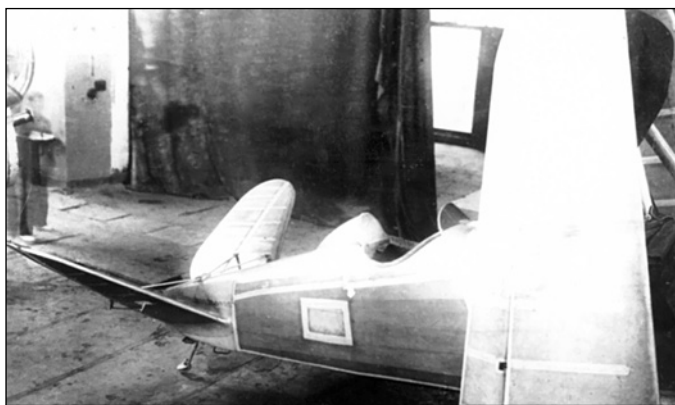
А-8 с V-образным оперением и сложенными крыльями
